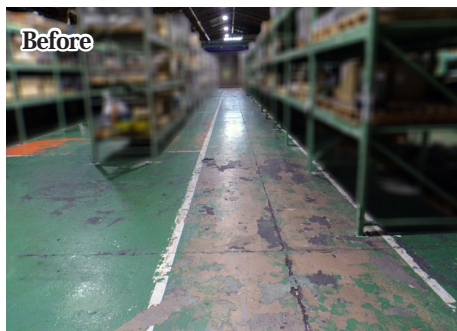
■倉庫 使用製品: 床塗料シリーズ 密着!! コンクリには(グリーン)
